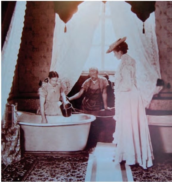
Spa bathroom, 1890, Františkovy Lázně
