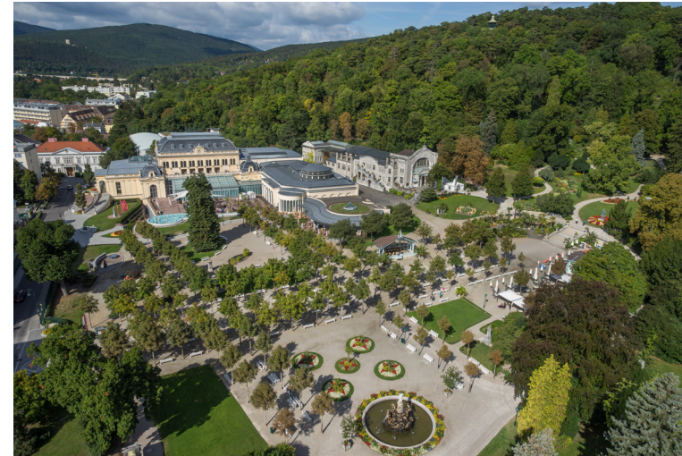
Blick auf das Casino Baden (ehemals Kurhaus) im unteren Kurpark.
